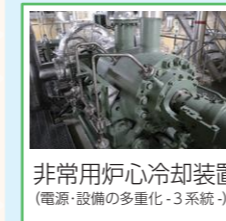
+ 高圧代替注水ポンプ (制御電源不要)
