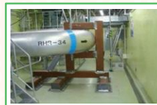
配管等の支えを追加
