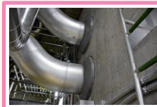
+ 配管貫通部 止水処理
