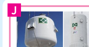
+ フィルタベント設備
