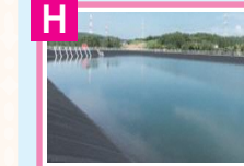
+ 貯水池 (約 20,000t) 復水貯蔵槽 (約 1,700t)
