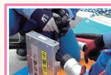
+ 電源復旧訓練
