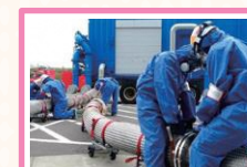
+ 代替熱交換器車接続訓練
