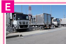
+ ガスタービン発電機 (4台)
