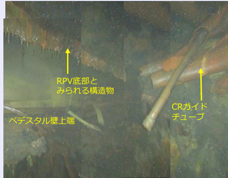
ペDESTAL内 RPV底部付近
