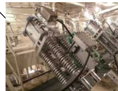
主蒸気隔離弁
