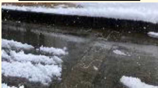
消融雪施設の設置
