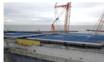
3号機タービン建屋 損傷部補修
