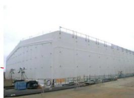
多核種除去設備（ALPS）
