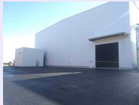
10-C棟の外観（2025年2月17日）
