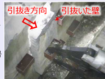
<壁引抜作業の様子>
