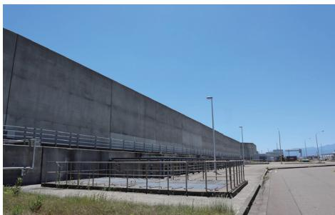
海拔5mの敷地に高さ約10mの鉄筋コンクリート製の堤防（敷地の高さと合わせて海拔15m）を約1.5km設置しています。
