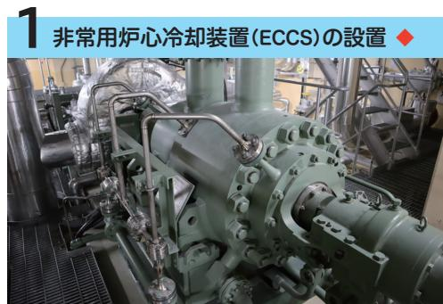
電源駆動のポンプや原子炉の蒸気を駆動源としたポンプを用いて原子炉へ注水します。
