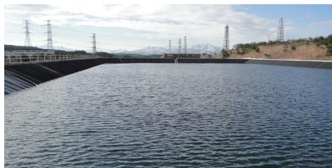
原子炉などに供給する冷却水の水源を強化する目的で、海拔約45mの高台に設置しました。貯水容量は約2万トン。
