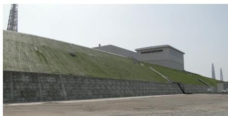
海拔12mの敷地にセメント改良土で高さ約3mの盛土をした堤防（敷地の高さと合わせて海拔15m）を約1km設置しています。
