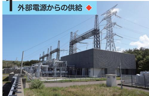
発電所外部から必要な電力を受電できるように、外部電源(送電線)を5回線用意しています。
