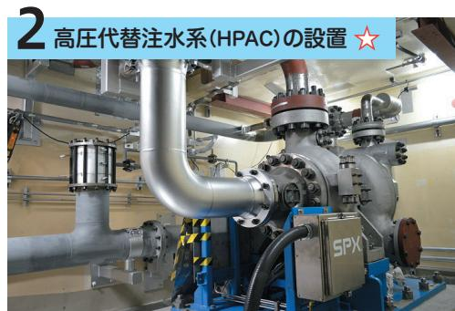
高圧系のECCSが起動・運転継続できない場合、あるいはすべての電源を失った場合に、原子炉の蒸気を駆動源にしてポンプを回し原子炉へ注水します。
