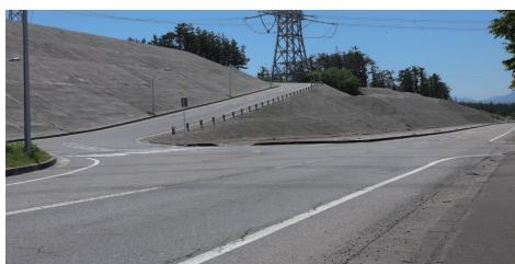
発電所構外で火災が発生した際に防護対象設備への延焼被害を食い止めるため、可燃物のない帯状の区域を確保しています。
