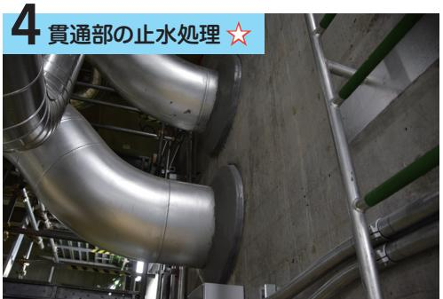
重要エリアでは、配管やケーブルなどが壁や床を貫通している部分をシリコンゴムで塞ぐなどの止水処理も施しています。
