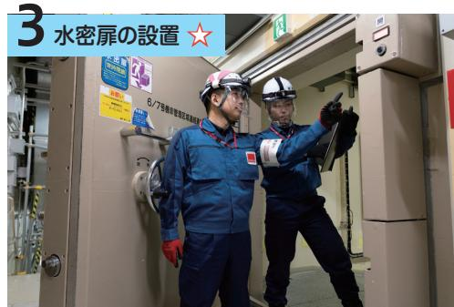
浸水を防げなかった場合を想定し、事故時に原子炉を冷却する装置や非常用電源などが設置されている重要エリアは水密化を図っています。
