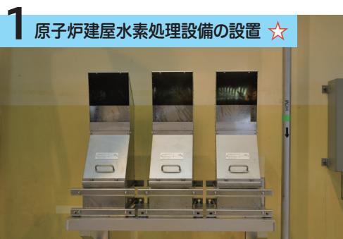
電気を使わずに触媒の働きにより、水素と酸素を水蒸気に変え水素濃度の上昇を抑えます。原子炉建屋最上階に設置しています。
