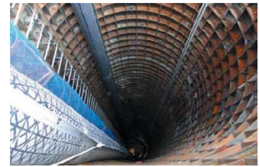
深さ約30mの断層調査用立坑
