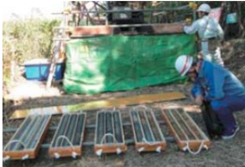
ボーリング調査
