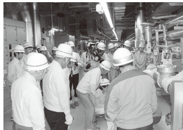
16.9.12 発電所4号機視察
