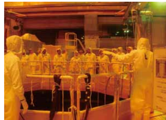
15.6.1 発電所7号機視察
