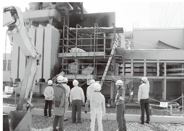
19.8.1 中越沖地震関連 発電所状況確認
