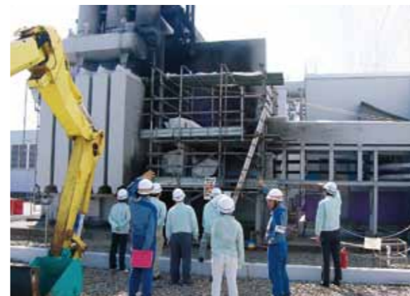
19.8.1 中越沖地震関連 発電所状況確認
