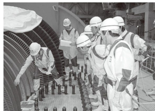
19.12.9 中越沖地震関連 発電所状況確認
