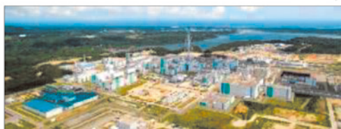
再処理施設 全景
