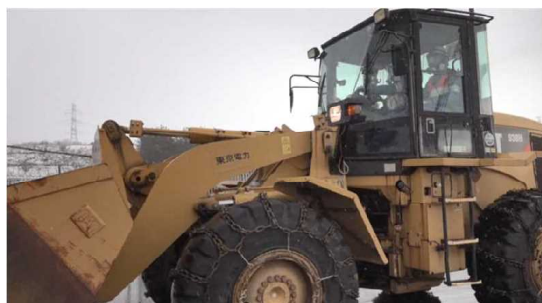
ホイールローダーを使用したがれき撤去
