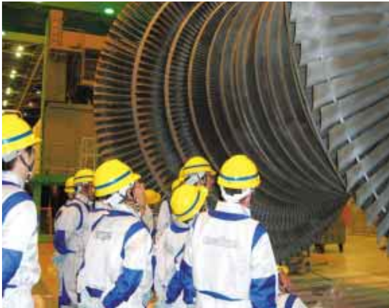
▼柏崎刈羽原子力発電所7号機視察（タービン点検）
