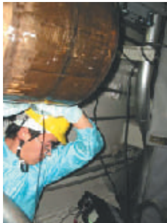
超音波探傷検査状況
