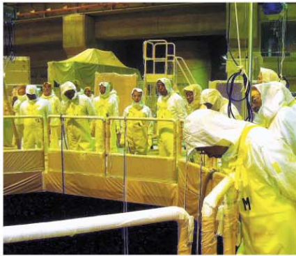
3号機・シユラウドの補修状況
