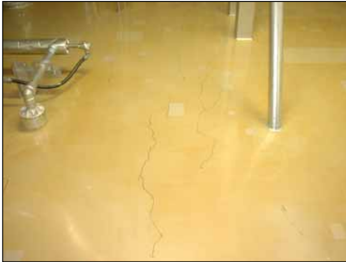
ひび割れ発生箇所をマーキングする。
