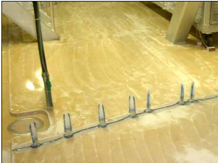
注入器(注射器のようなもの)を設置し、ゴムの力で、ひび割れに樹脂を注入する。
