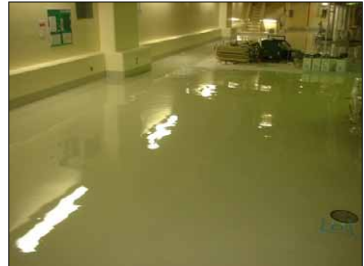
樹脂注入完了後、床塗装を行う。
