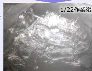
＜低圧水による堆積物除去の様子＞
