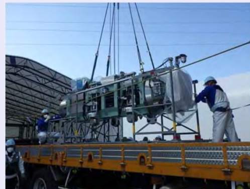
<堆積物除去装置の運搬状況>
