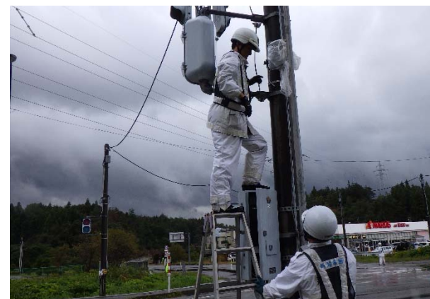
信号機の復旧
