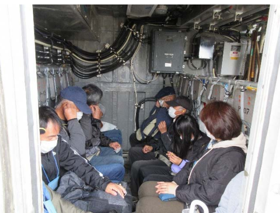
人員輸送用コンテナの様子
