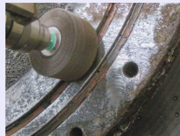
<X-6ペネ フランジ面の清掃の様子>
