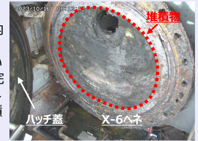
<X-6ペネハッチの開放後の状況>
