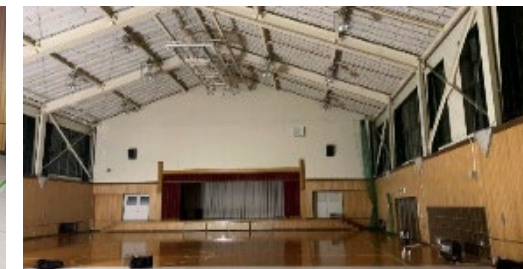
LED照明のみで照らした コミュニティセンターの体育館内
