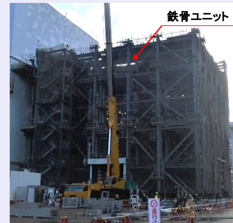
<2号機原子炉建屋南側作業の様子> (撮影：2023年8月10日)
