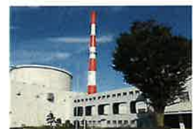
高速実験炉「常陽」
