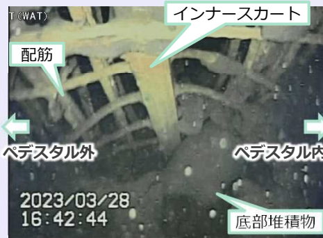
＜ペDESTAL開口左側配筋の状況＞
