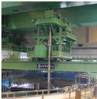
燃料取替機全体
