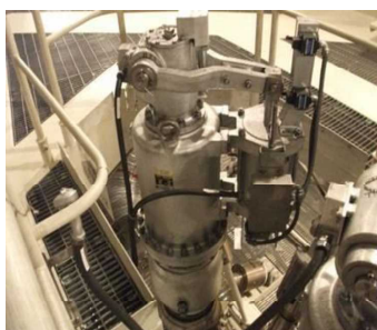
④主蒸気逃がし安全弁
