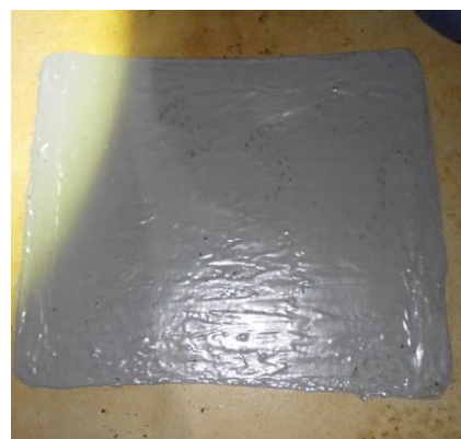
配管内側（補修後）
