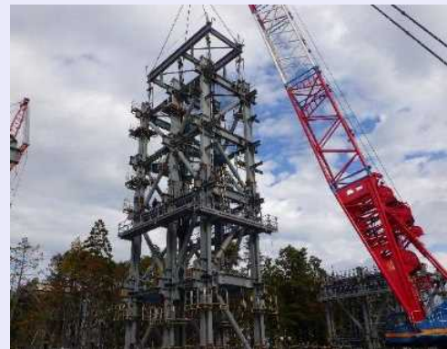
＜鉄骨ユニット接合確認状況(2022年11月5日)＞
