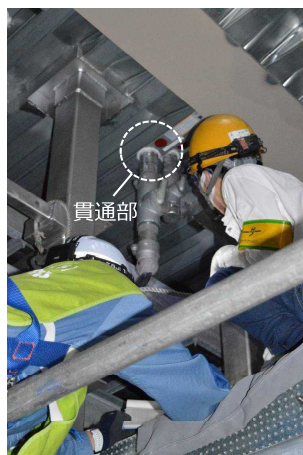
高所にある貫通部は足場を組んで確認
