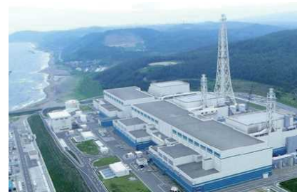
柏崎刈羽原子力発電所
