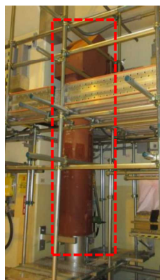
耐火材の巻き付け
