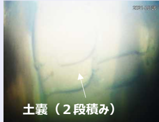
土嚢（2段積み） ＜確認されたゼオライト土嚢の状況＞
