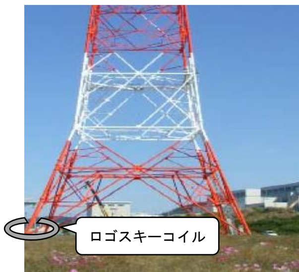
(a) 避雷鉄塔下部状況
