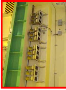
静的触媒式水素再結合装置 (PAR)
