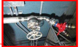
使用済燃料プールに注水するための外部接続口
