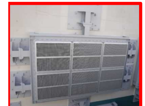
電巻防護ネット (複数箇所)
