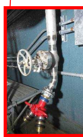
使用済燃料プールに注水するための外部接続口
