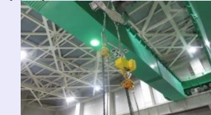
＜天井クレーン主巻での収納缶吊り具の取り扱
