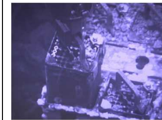
燃料取り出しの状況 (撮影日2019年4月15日)
