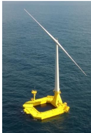
＜水深の浅い海域・港湾でも利用可能な低コスト浮体式洋上風力発電システム実証機＞
