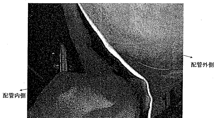
復水配管のオリフィス下流側から脱気器方向 へ見た左周方向内側破断面(c方向から撮影)
