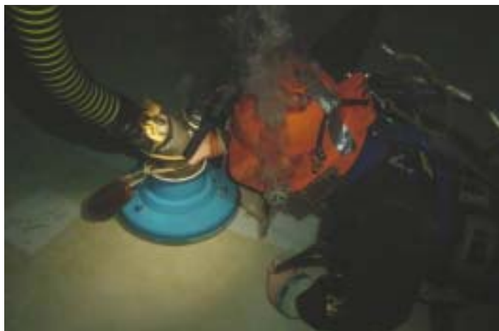
ダイバーによる潜水作業 (S.G.Pinney&Associates.inc.提供)
