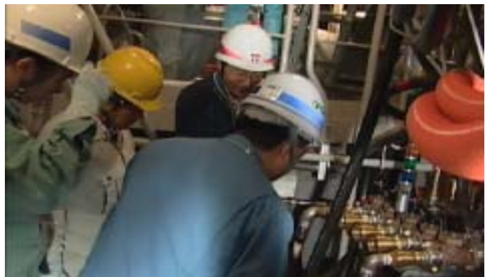
現場パトロールの様子
