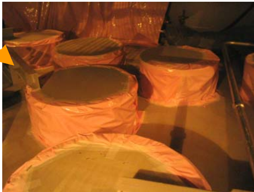
(ビニールシート養生)
