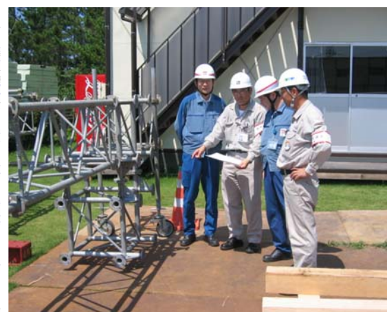
試験施工による安全性確認
