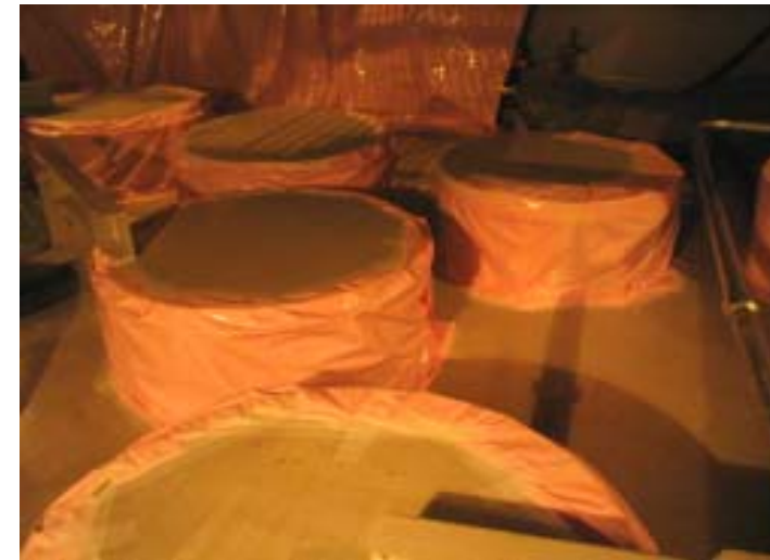
(ビニールシート養生)
