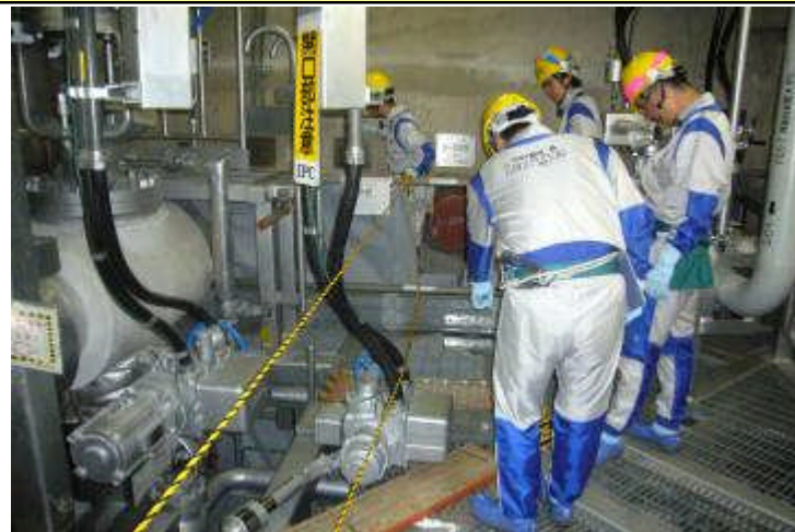
作業現場確認状況
