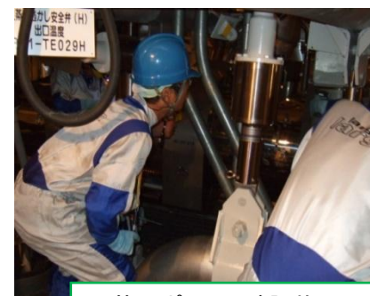
配管サポートの確認状況
