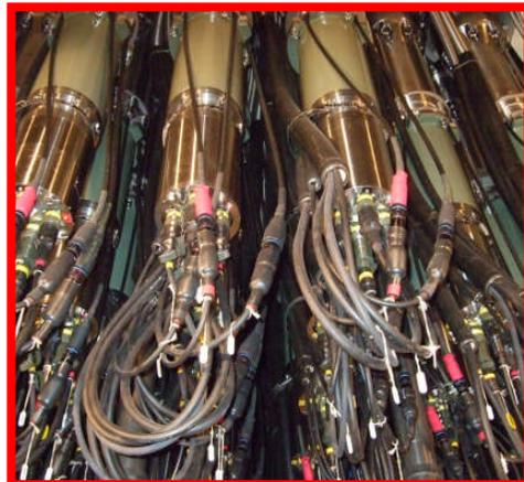
制御棒駆動機構(205台)
