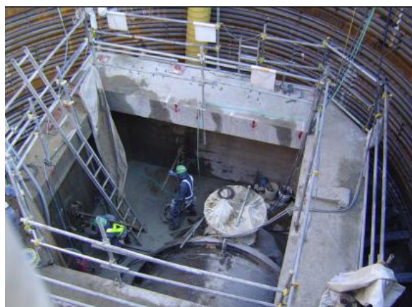
循環水配管点検(1号機)
