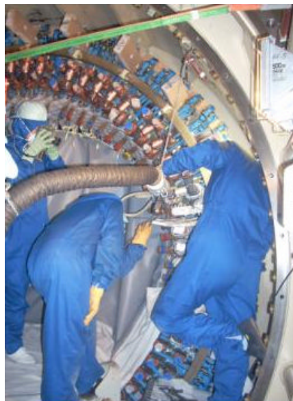
発電機コイルの点検(4号機)
