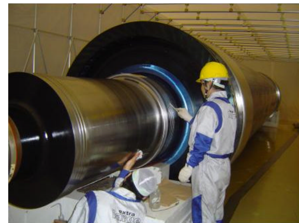
発電機ローターの点検(5号機)
