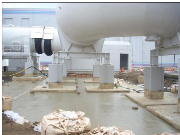
主排気ダクト基礎部改良(2号機)
