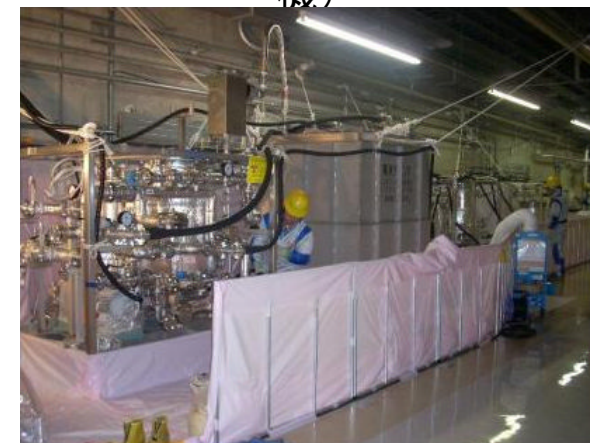
原子炉再循環配管 化学洗浄装置(2号機)
