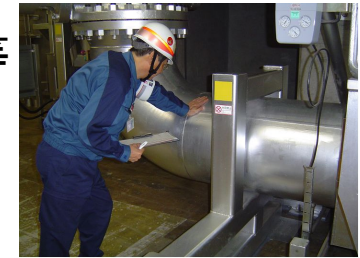
配管の振動確認を実施
