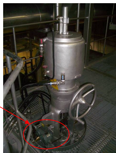
給水流量調節弁 (大弁)
