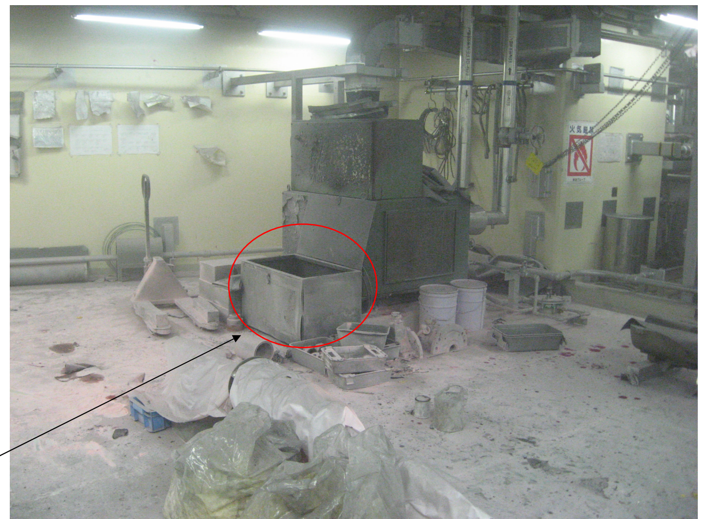
火災現場状況
