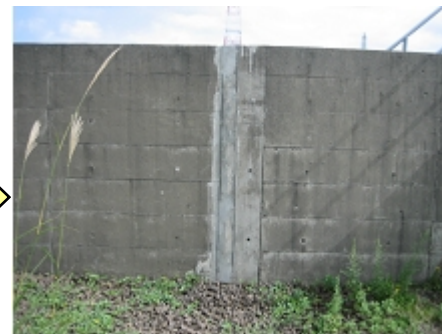
重油タンク防油堤での目地の開き
