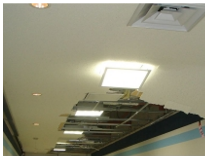
中央制御室通路前天井の損傷 (4号機)
