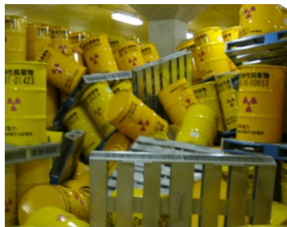
ドラム缶の転倒 (固体廃棄物貯蔵庫)
