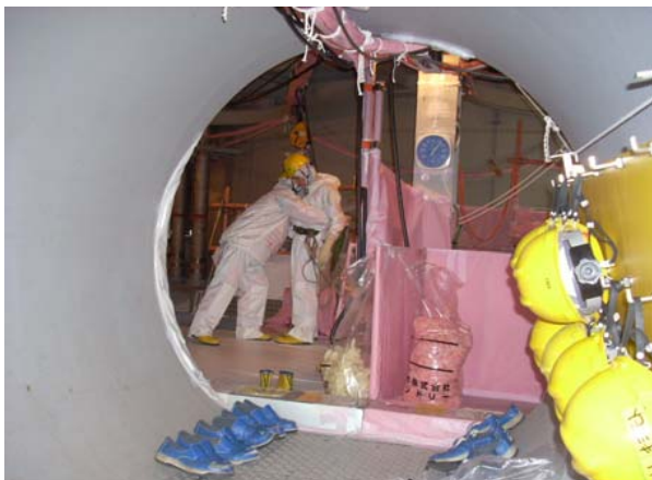
7号機 圧力抑制室の点検
