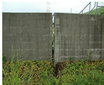
重油タンク防油堤での目地の開き
