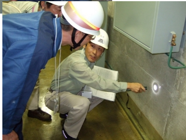
原子炉建屋耐震壁の点検
