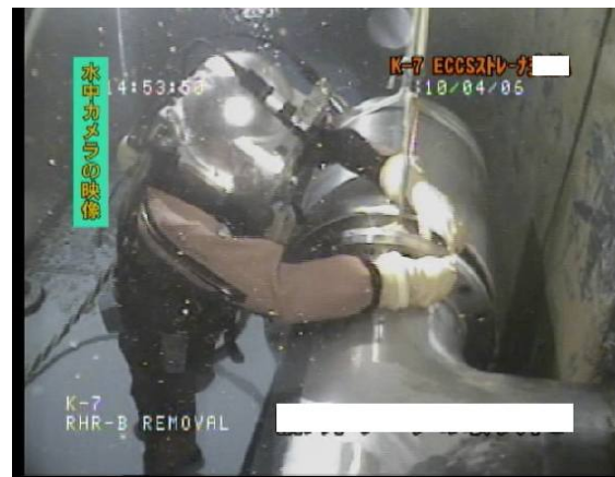
7号機 圧力抑制室の点検(潜水作業)
