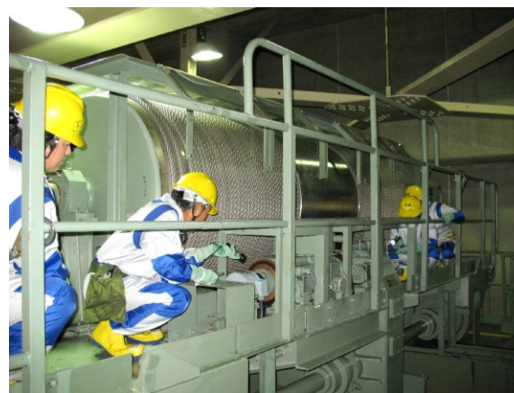
2号機 天井クレーンの点検
