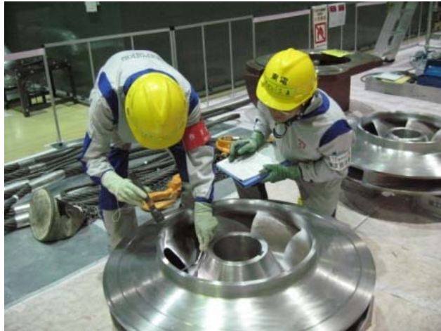
1号機 低圧復水ポンプの点検
