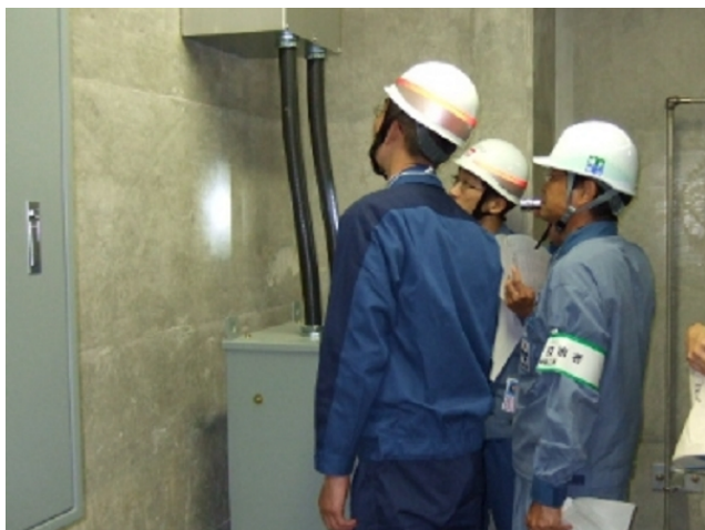
(7号機) 原子炉建屋耐震壁の点検
