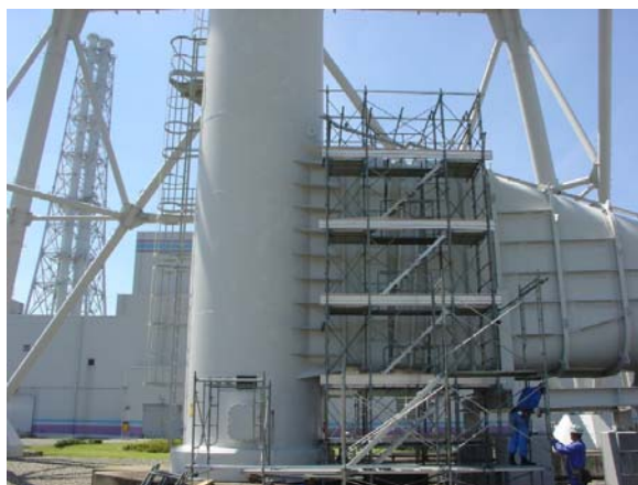
3号機 排気筒の点検
