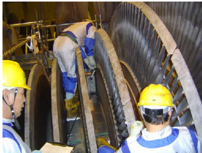
7号機 タービン翼の点検
