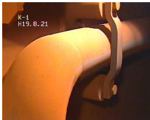
1号機 炉心スプレイ配管
