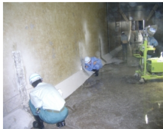
7号機 非常用取水路の点検
