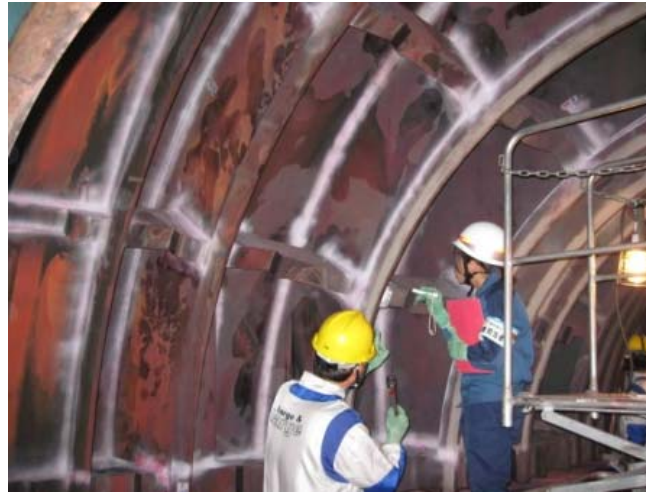
3号機 タービン本体の点検
