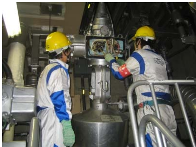
1号機 残留熱除去系弁の点検
