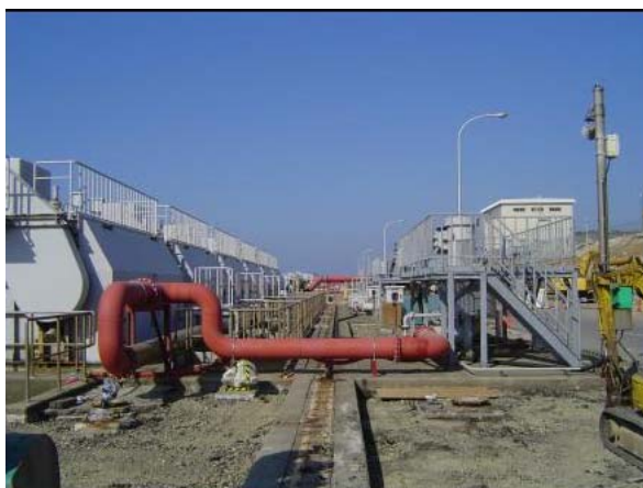
スクリーン設備点検・修理
