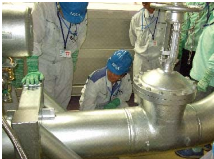
耐震強化工事
