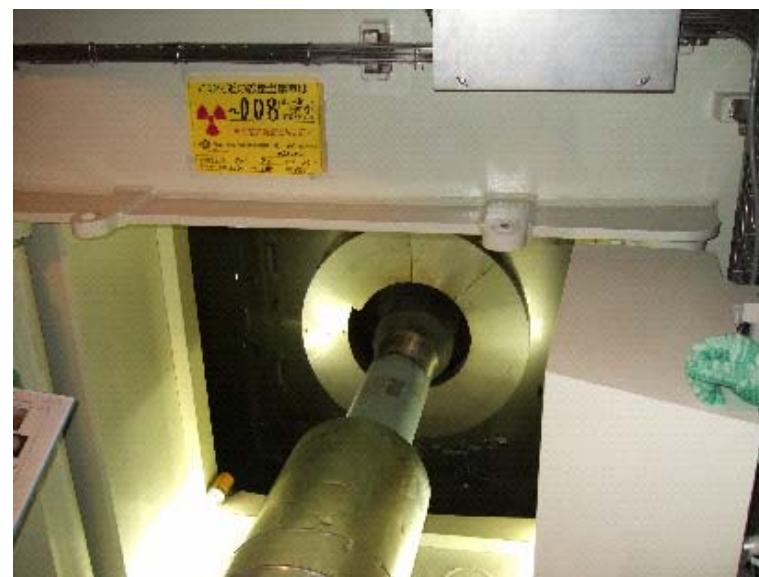
解析の結果裕度の少なかった設備(低圧注水ノズル)
