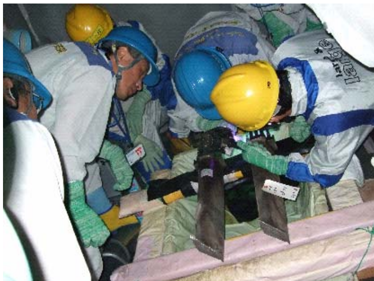
低圧タービン分解点検
